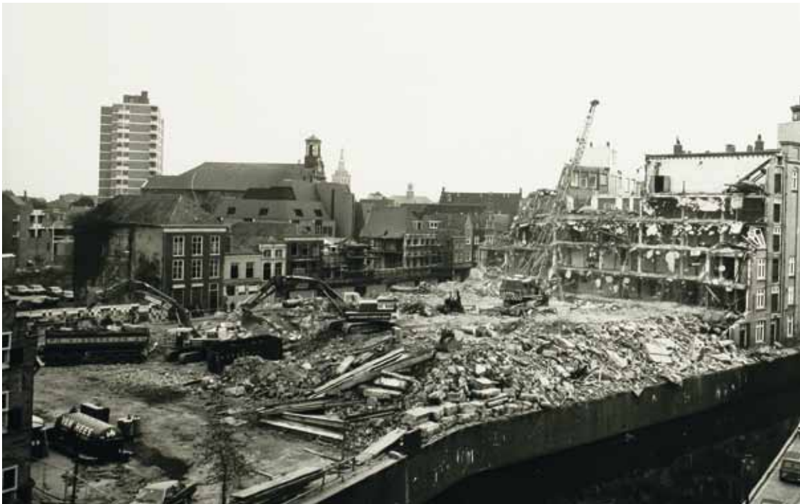
Sloop De Gruyter fabriek
